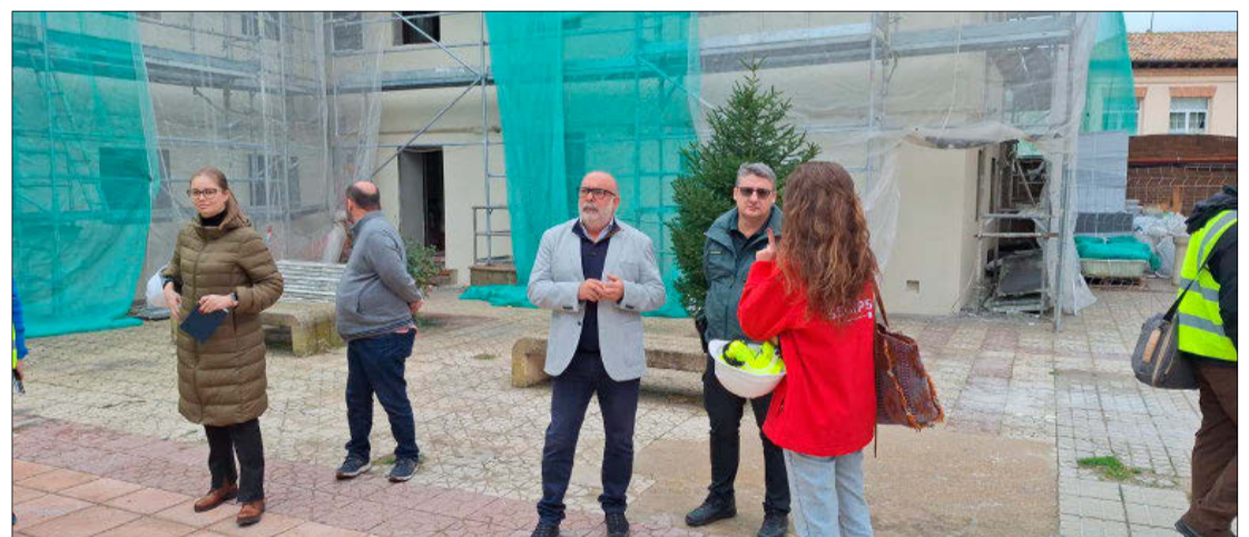
El subdelegado y el teniente coronel durante la visita a las obras del acuartelamiento. HDS
